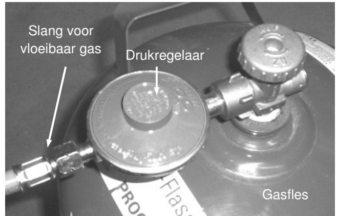
Afb. 1: Aansluiting aan de gasfles
